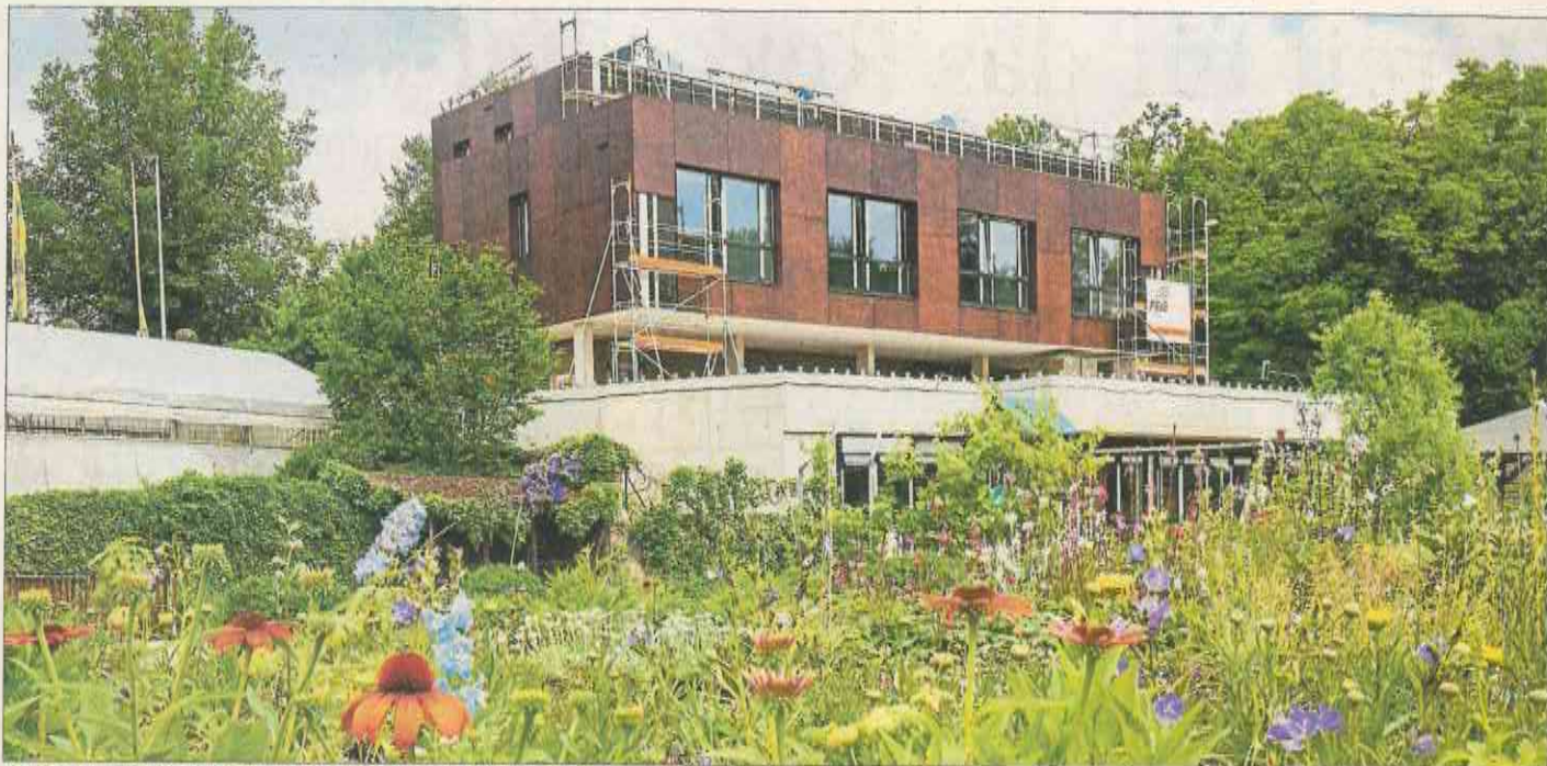
Direkt an der Schutter und der Gärtnerei Trögl liegt der neue Schabmüller-Firmensitz, dessen braune Fassade jetzt sichtbar ist. Foto: Hammer
