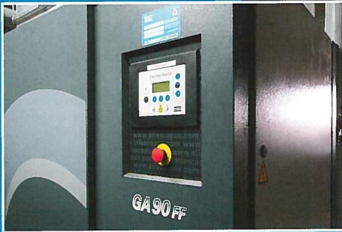
Rund 90 °C heißes Wasser verlässt die in das Kompressorengehäuse integrierte Wärmerückgewinnungs-Anlage. Über Wärmetauscher lassen sich die Bäder für die Teilereinigung komplett mit Abwärme beheizen. Die elektrische Alternative bleibt ausgeschaltet – und das über das ganze Jahr hinweg.
